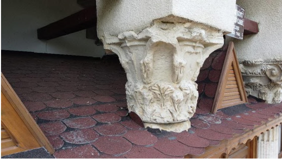
Görsel 26: Duruçay Köyü Halil Bey Camii Devşirme Sütun başında meydana gelen erozyon Kaynak: G. Gökgöz Gedik, 2022
